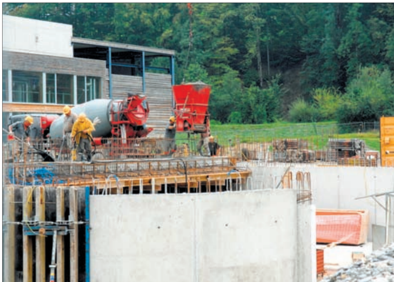
Die Bauarbeiten für das neue Bevölkerungsschutzzentrum haben begonnen.
